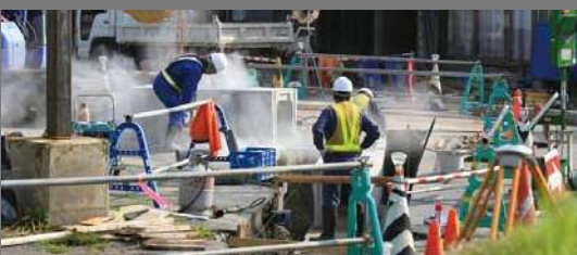
土木・工事現場
