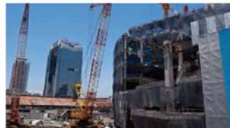
建設現場の作業連絡
