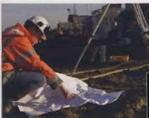
建設・工事現場での業務連絡
