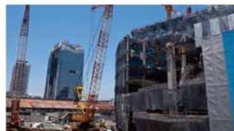
建設現場の作業連絡
