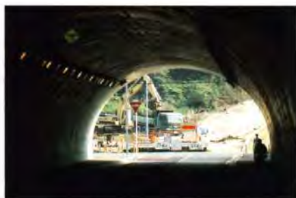
●トンネル工事●各種の地下工事●ビル建築現場
