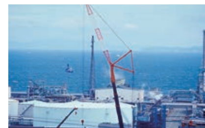
工業・流通施設
