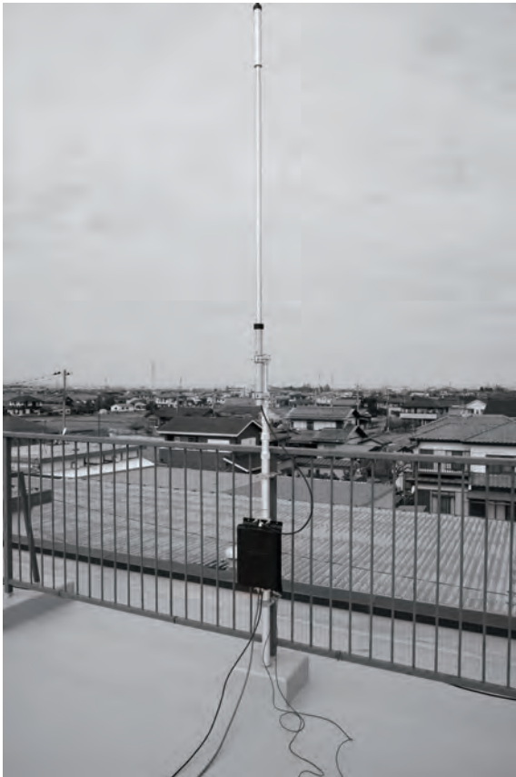
(写真1) 手すりの支柱にマストポール(DAP600)を固定し、エレメントをマスト先端に据え置き、ATUはマストに固定した例
